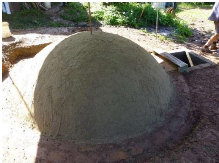
Figura 7 – Biodigestor para biogás. Fonte: Permaculture Research Institute.
