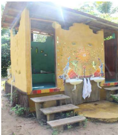
Figura 18 – Fachada banheiro seco
