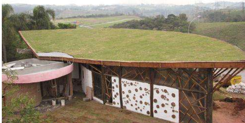
Figura 9 – Telhado Verde Fonte: Fundação Getúlio Vargas
