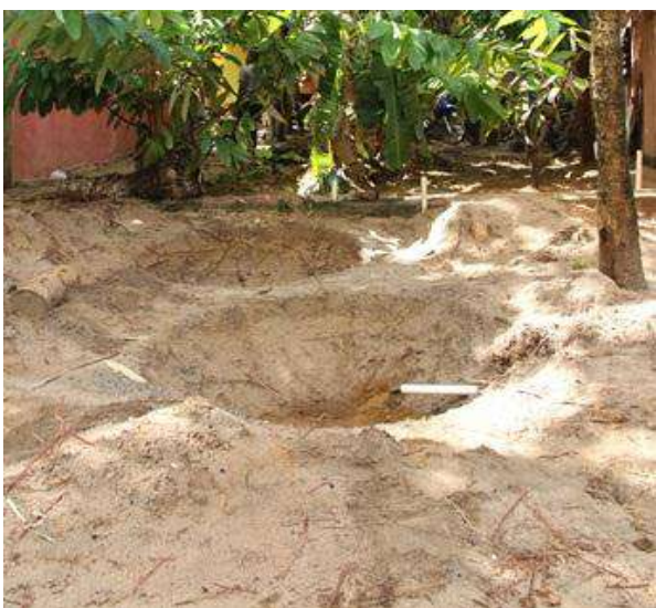
Figura 12 – Filtro para águas cinzas em construção
