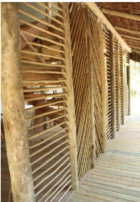
Figura 24 – Paredes vazadas
